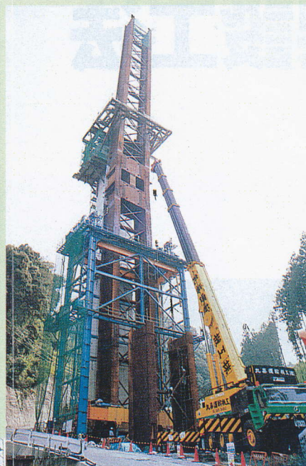
③ジャッキアップ挿入完了
